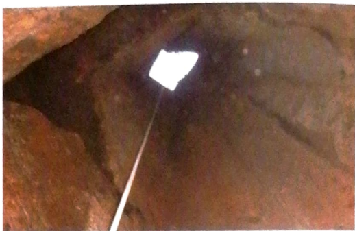
Εσωτερικό μεταλλευτικού φρέατος Interior of a mining shaft
