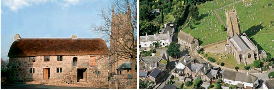
Abbildungen 2–3: Das seit 1524 schriftlich belegte, aber bereits im 15. Jahrhundert unmittelbar am Rande des Kirchhofes von St Andrew erbaute church house von South Tawton in der Grafschaft Devon. Fotos verwendet mit freundlicher Genehmigung von Robin Tilley, South Zeal.
