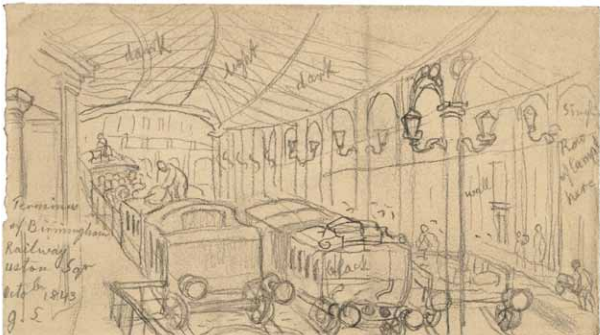
Fig. 6 - Terminus du N. W. Railway, Euston Square: intérieur de la gare, avec des trains sur trois voies, et des personnages, incluant à droite peut-être un portier, poussant un chariot, 1843. Graphite sur papier par George Scharf (1788–1860). Scharf est né en Allemagne, il travaille à Munich et émigre en Angleterre en 1816. BM Prints & Drawings 1862.0614.419 © The Trustees of the British Museum.
