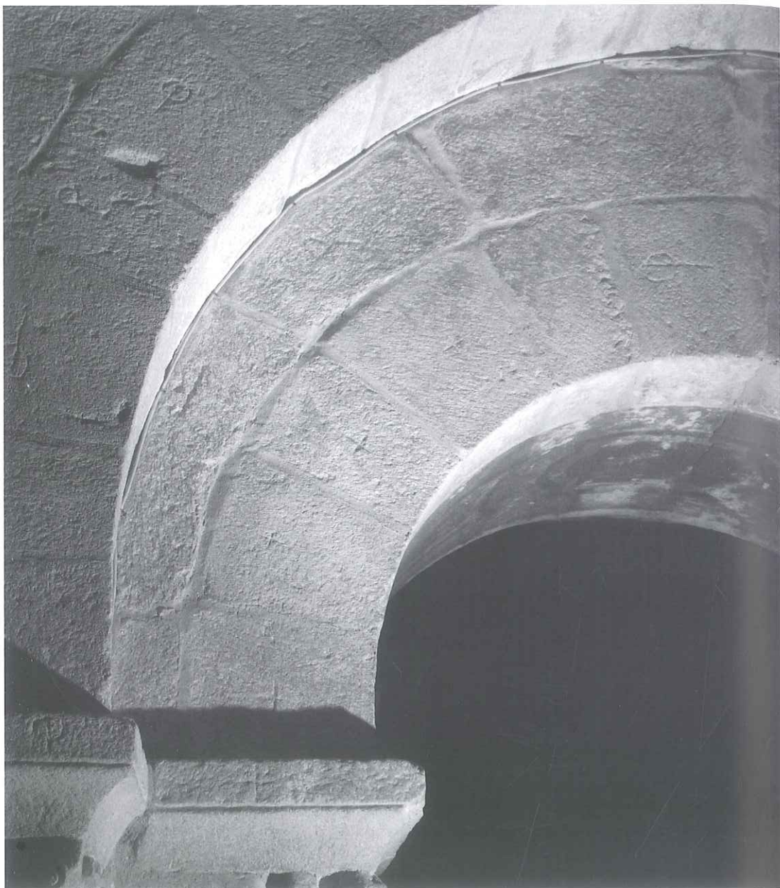
Fig. 13. Tribuna, arcos del tramo axial, dovela que indica corrección sobre la marcha (Foto: autoras).
