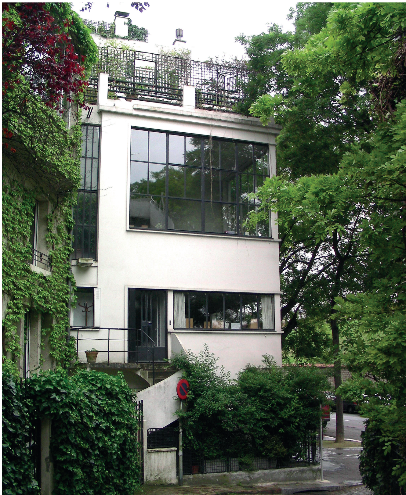
Ill. 3. Le Corbusier: Ozenfant house, 1923. Ave Reille/rue du Square Montsouris, Montparnasse. Photo: G. Todaro.
